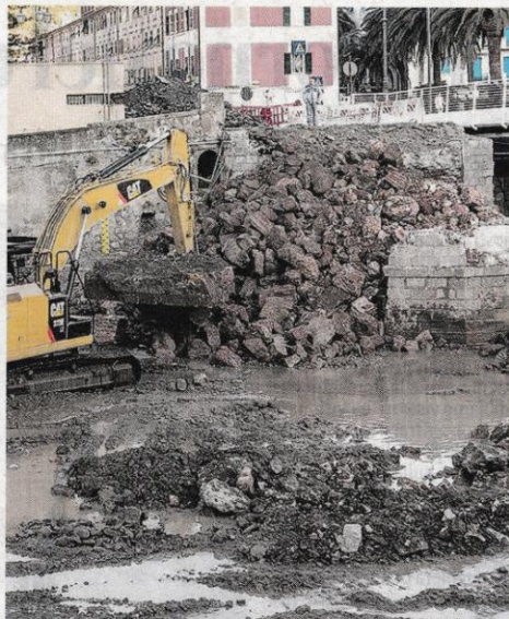
La demolizione del vecchio ponte di Riva Trigo
